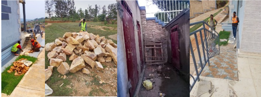
Umbaumaßnahmen: Rampe, Toiletten
