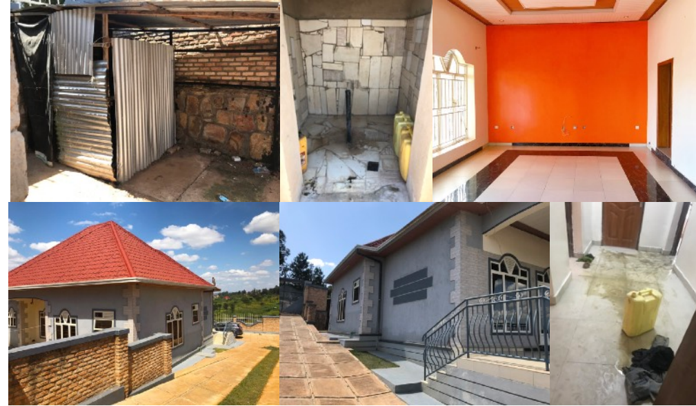
Haus bei der Übernahme, vor dem Umbau
