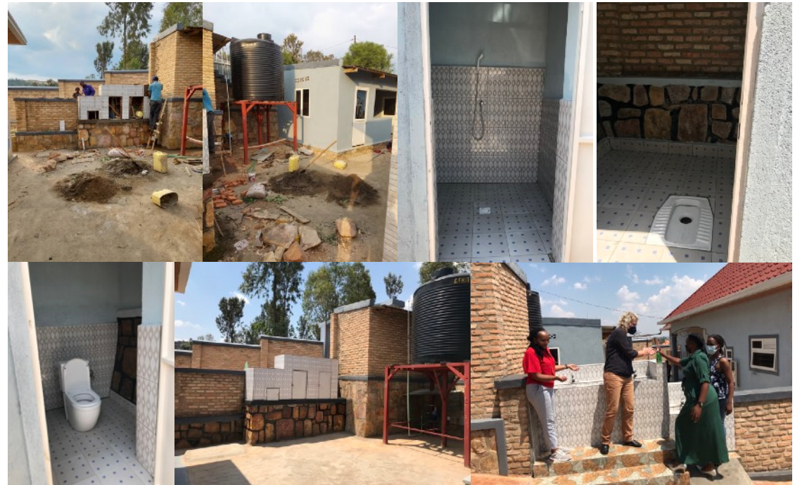
Umbaumaßnahmen: Sanitäranlagen, Handwaschbecken
